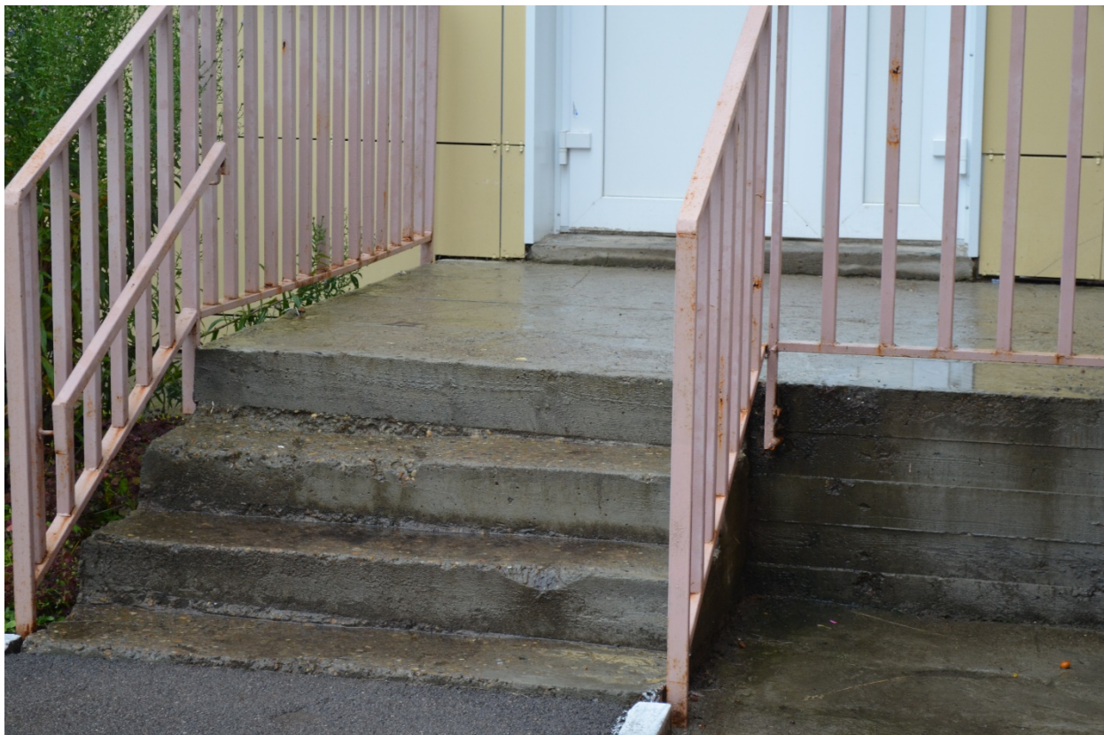
Фото№5. Лестница наружная
