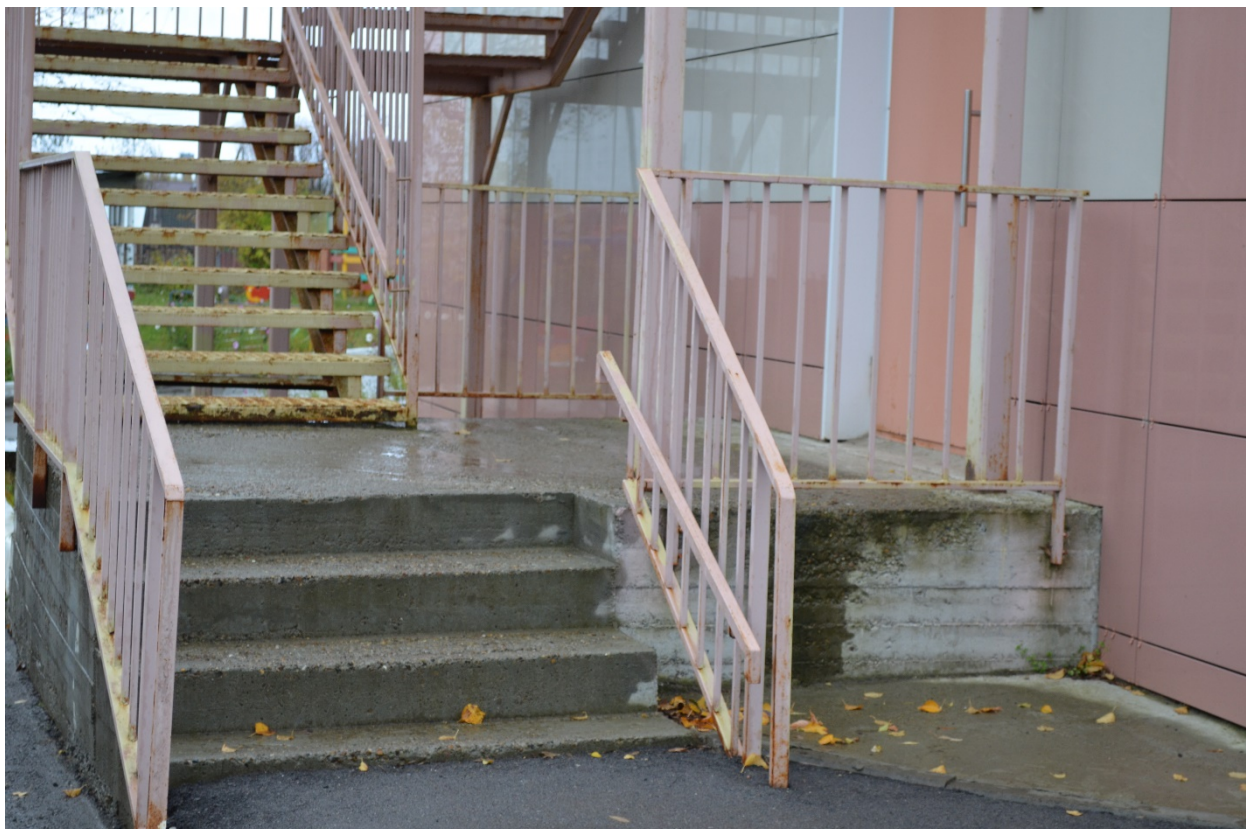
Фото№6. Лестница наружная(эвакуационный выход)
