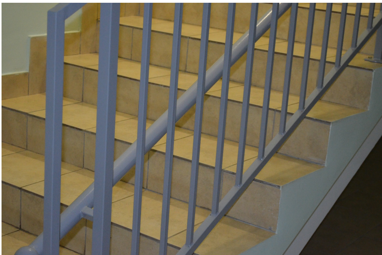
Фото №2. Лестница внутри здания
