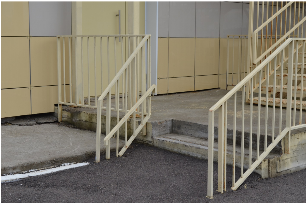
Фото №11. Наружная лестница
