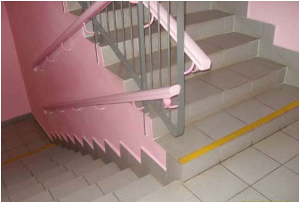
ФОТО 10 Лестница внутри здания
