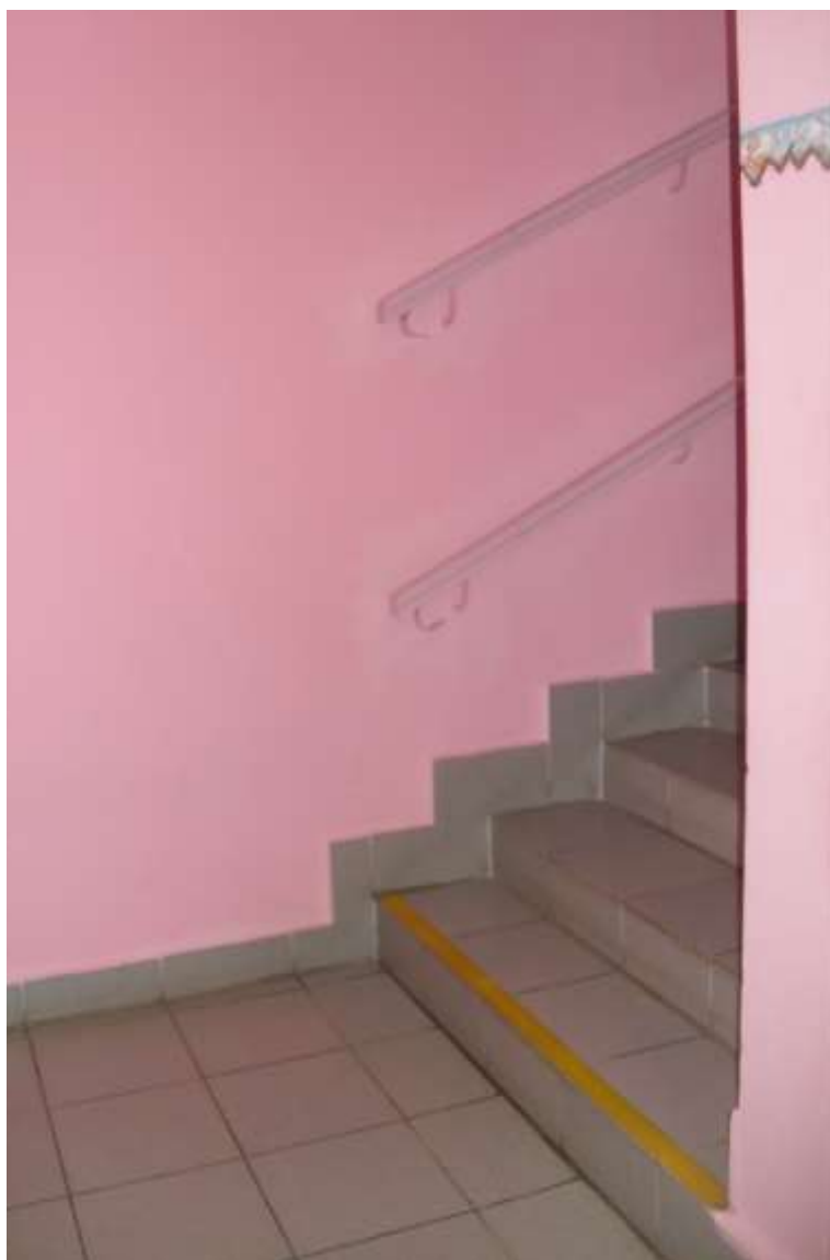
ФОТО 9 Лестница внутри здания
