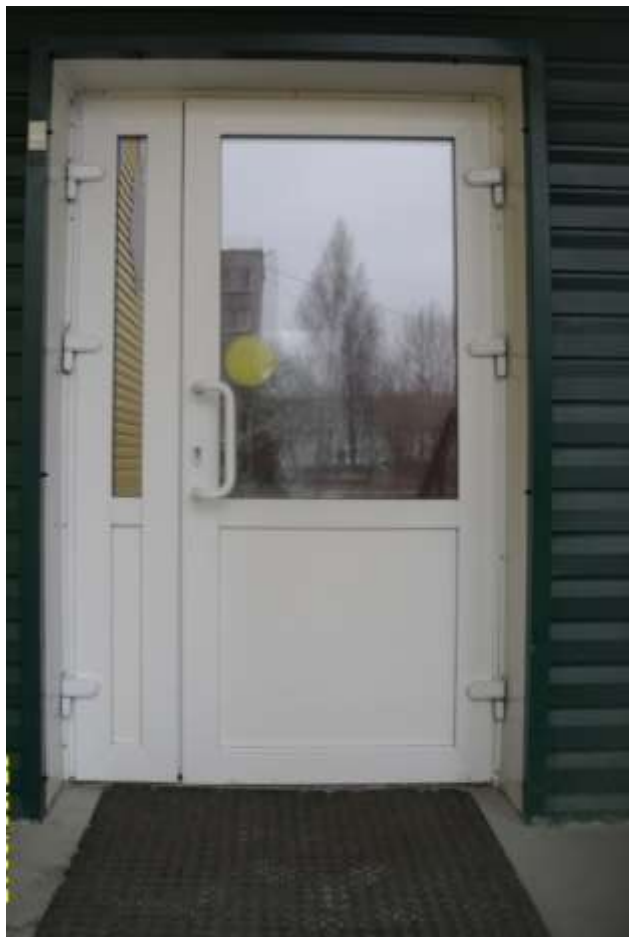
ФОТО 6 Вход (выход) в здание ДОУ, входная площадка перед дверью, входная дверь
