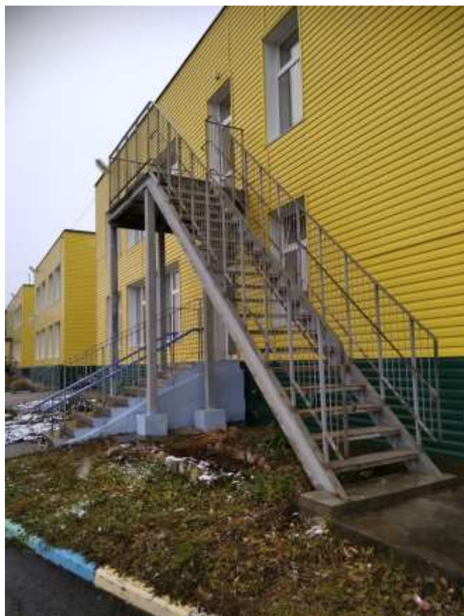
ФОТО 19 Эвакуационные пути из здания
