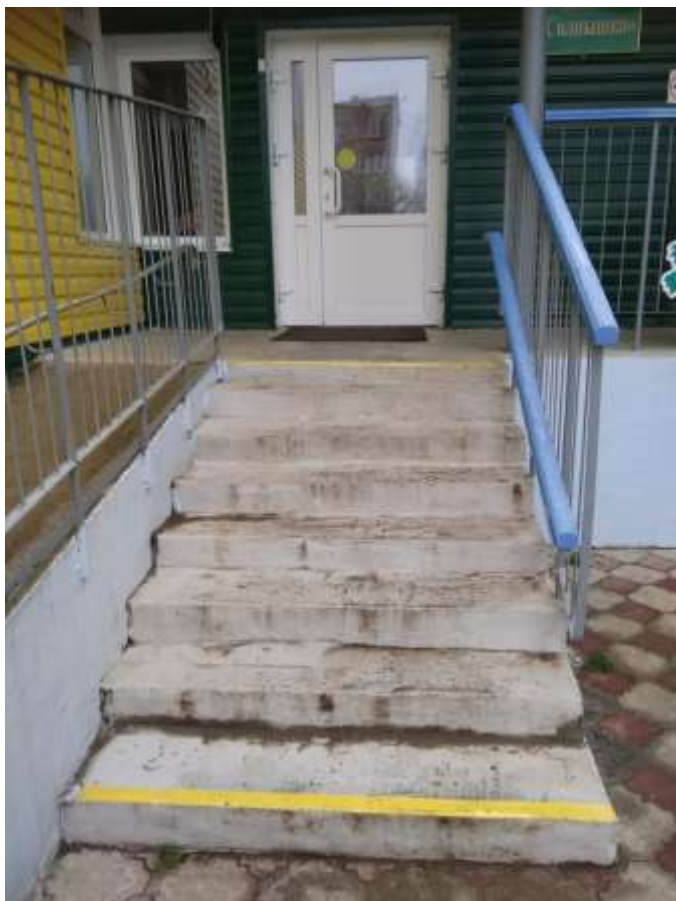
ФОТО 5 Вход (выход) в здание ДООУ, лестница наружная
